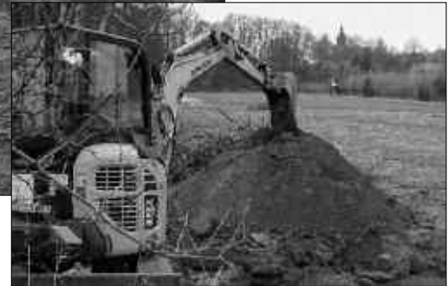
Anlage von Entwässerungsgräben
