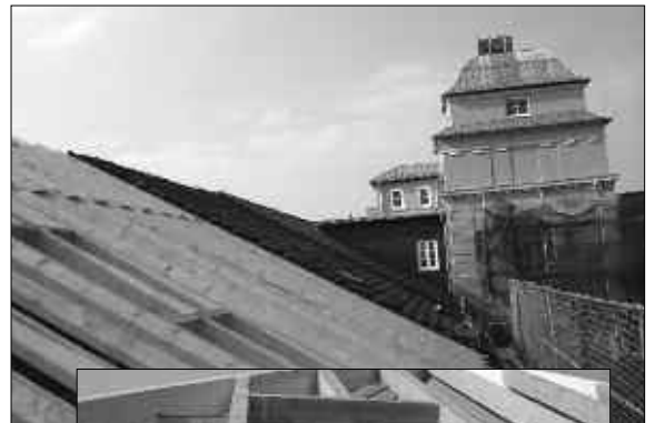
Die Dachsparren auf der neuen Mittelschule wurden gesetzt.
