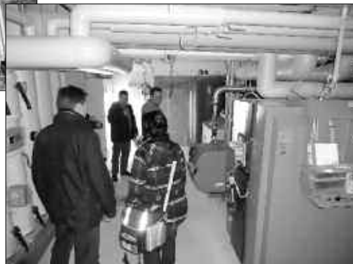
Haustechnikzentrale: Hier wird nach den Planungen von Prof. Reichel aus Gas Strom und Wärme für die Mittelschule. Überkapazitäten von elektrischer Energie können zusätzlich ins öffentliche Netz eingespeist werden.
