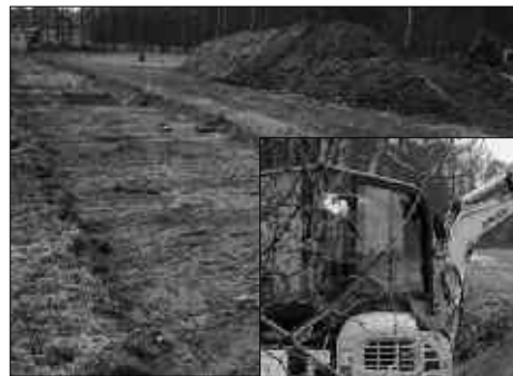
Anlage von Entwässerungsgräben
